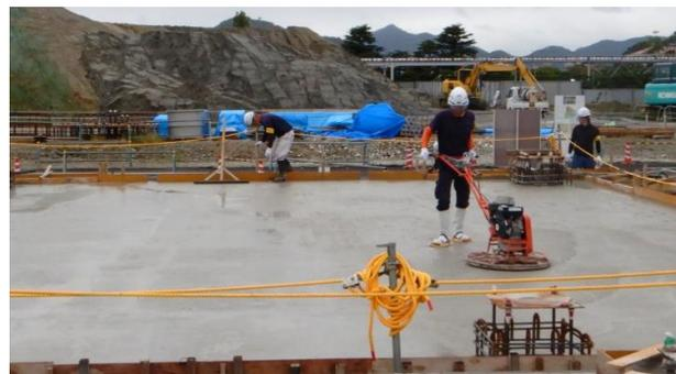
▲コンクリートの表面を平らに整えています。この後、コテを用いて更に整えていきます。
