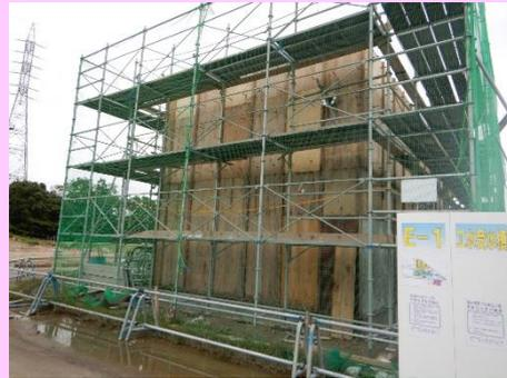
一見、木造の建物に見えますが、この木の板の中にはコンクリート製の工業用水の受水槽が出来上がっています。その他のタンクや排水設備等も建築中です。
