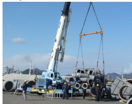
▲大型トレーラーで三田尻港の荷降ろし一次保管場所まで運び、工事進行に合わせて建設現場に運び込みます。
