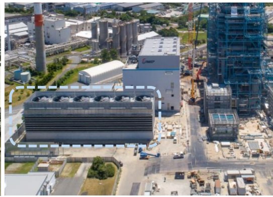
▲工水受水槽から発電所北に位置する冷却塔へ配管を伝って水が運ばれます。
