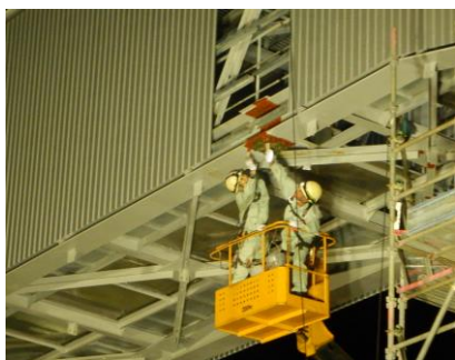
▲高所での取付作業の様子
