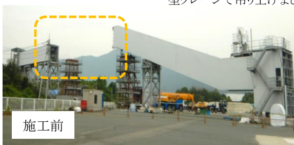
▲県道を跨ぐコンベアはおおよそ長さ55m、重さ52tと非常に重いため、大型クレーンで吊り上げました
