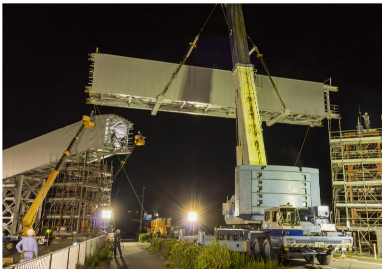
▲県道を跨ぐコンベアはおおよそ長さ55m、重さ52tと非常に重いため、大型クレーンで吊り上げました
